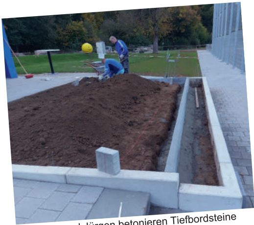
Nach der Sandschicht wird die Rasentragschicht aufgetragen
