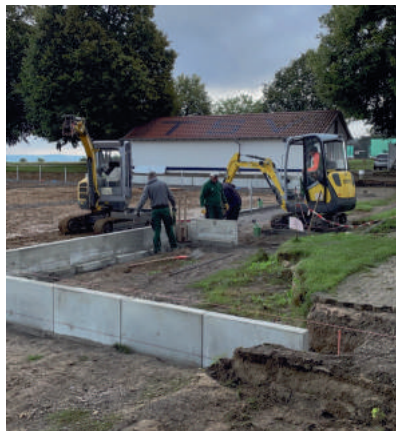
Setzen der Mauerseiben
