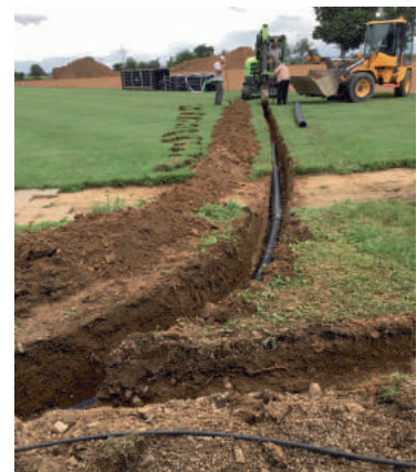
Verlegung der Sickerrohre
