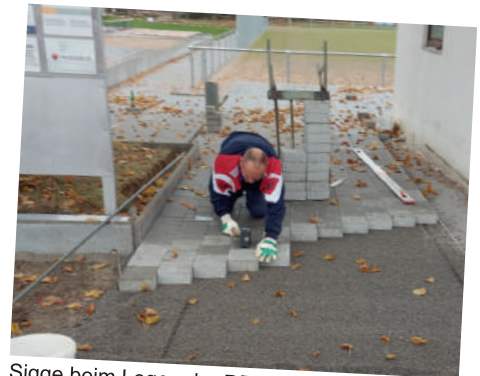
Sigge beim Legen der Pflastersteine
