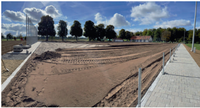
Nach der Sandschicht wird die Rasentragschicht aufgetragen
