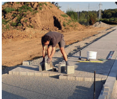
Klaus beim Legen der Pflastersteine
