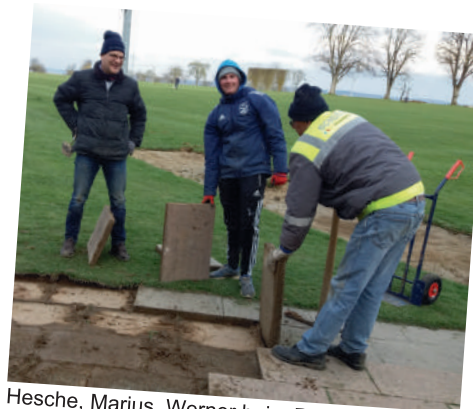
Abbau der Torhalterung
