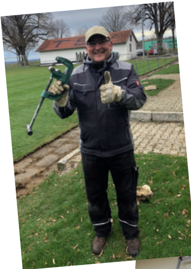
Ralf mit dem Rohrabschneider
