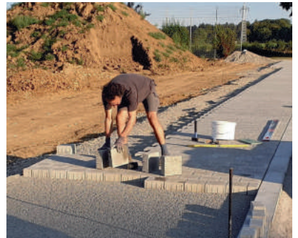
Klaus beim Legen der Pflastersteine
