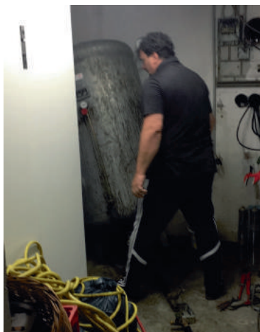
Volker erledigt die Wasserarbeiten
